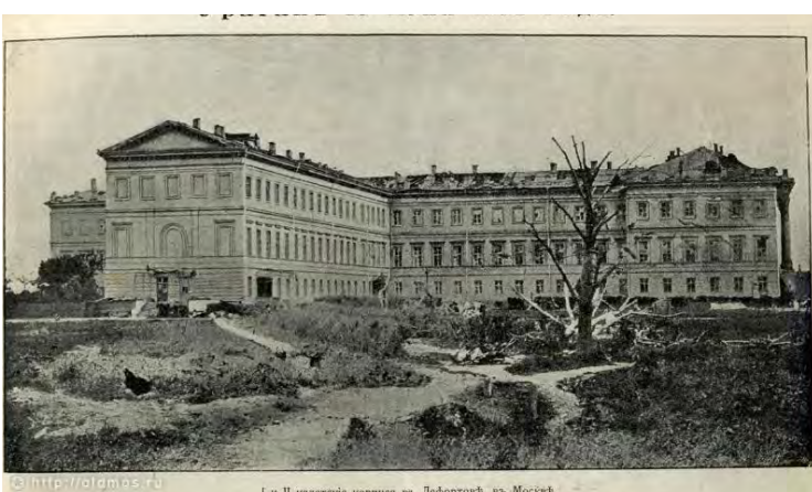
De stormschade aan het Annahof-paleis (sit. 1904)
